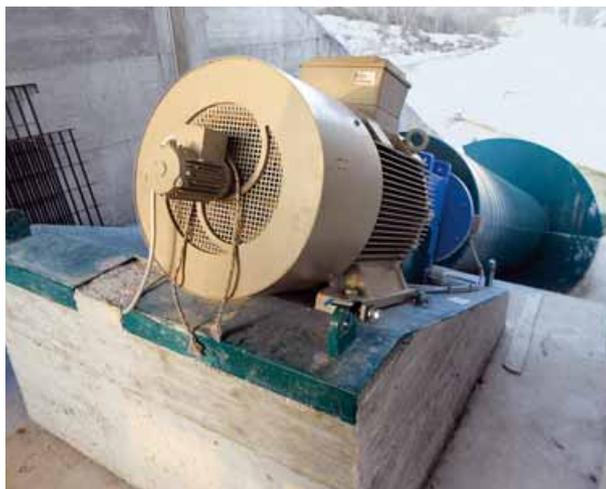
**Foto 4** Il generatore-alternatore montato in cima alla coclea. Foto RoncuZZi
