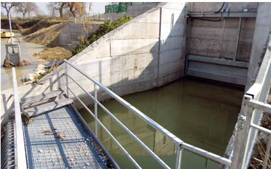
Foto 5 La griglia a maglie di 10 cm, in basso a sinistra nella foto, e la paratoia di regolazione della portata a monte della coclea. Foto Roncuzzi
