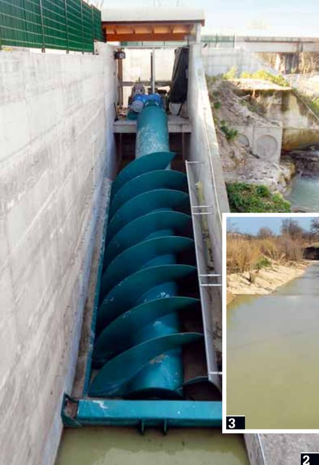
**Foto 2** La coclea installata nell'impianto di Serra de' Conti.
