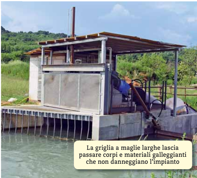
Foto 2 - Griglia installata nella parte a monte di un impianto micro-idroelettrico con coclea
